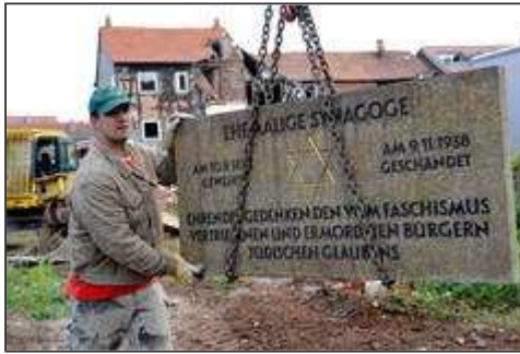
Renato Pietsch sorgte mit dafür, dass die Gedenktafel der Synagoge gerettet wurde - Auflage des Denkmalmamtes. Foto: Eckhard Jüngel
