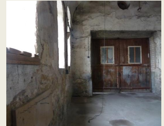
Heutige Innenansicht des Gebäudes
