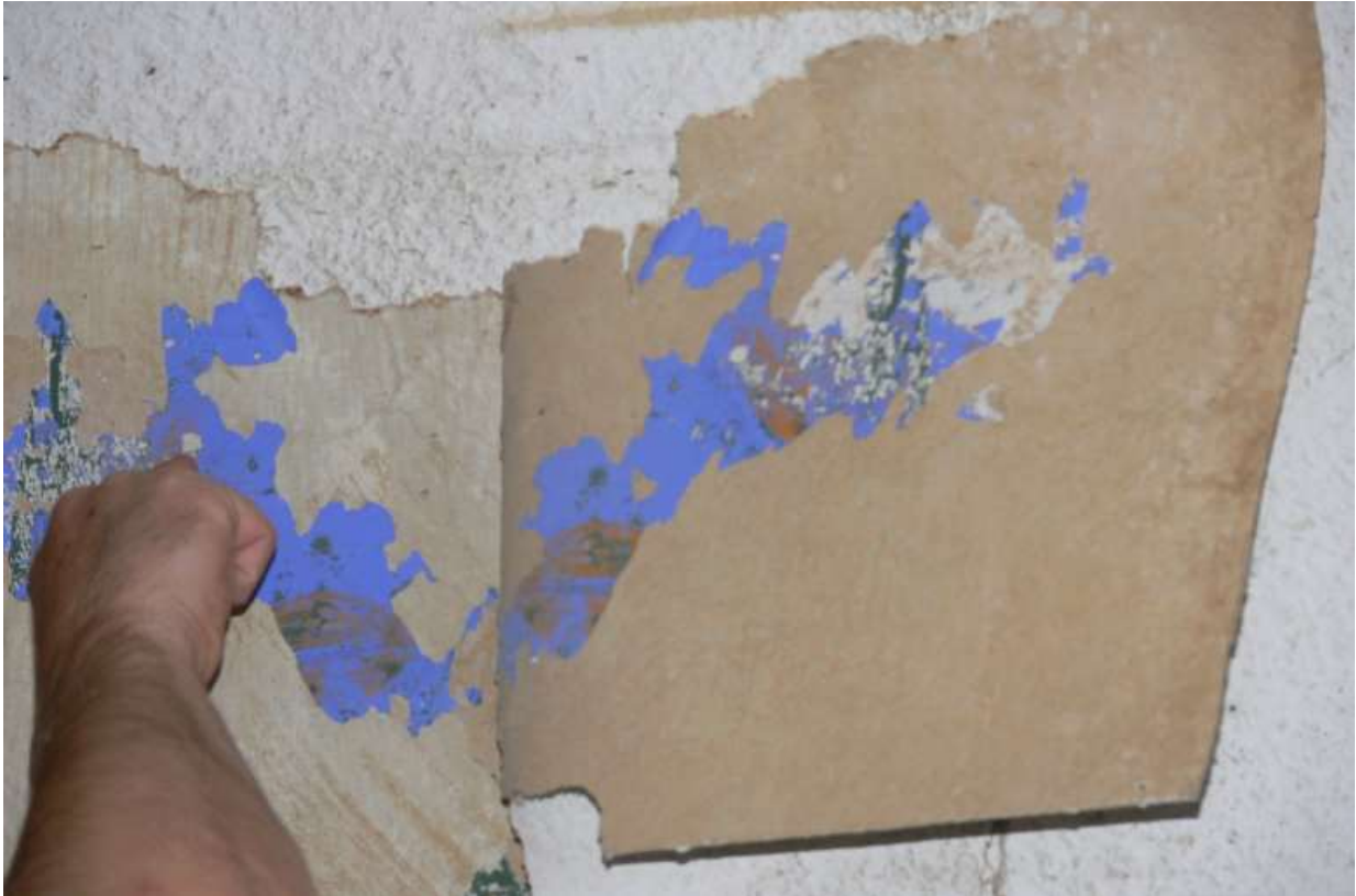
Rathaus Butzbach: Farbreste von dem Farbanstrich des ehem. Synagogensaals (Himmel mit Sternen), die Restaurator Stephan Born 2012 feststellen konnte.
