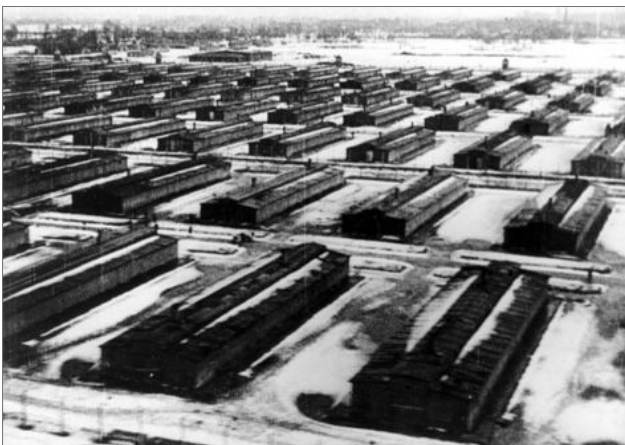
Luftaufnahme von KZ Auschwitz-Birkenau nach der Befreiung im Winter 1945 mit einem Blick auf ein Teil des Lagers. Im Gegensatz zu den Gebäuden des Hauptlagers, die aus Ziegeln gebaut wurden, waren es hier einheitliche Holzbaracken, in denen je Baracke 800-1.000 Gefangene hineingepfercht wurden. Es gab in ihnen kein funktionierendes Abwassersystem, keine Heizmöglichkeit und sie verfügten über keinerlei Wärmesolierung. (Foto: Staatliches Museum Auschwitz-Birkenau)
