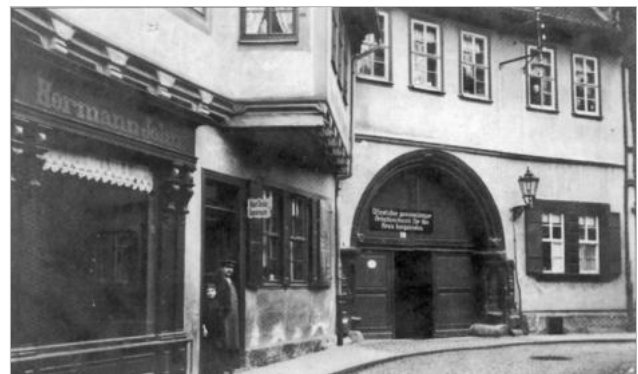
Blick auf das Gebäude Neue Gasse Nr. 9, 1970er Jahre. Hier befand sich im 1. Stock die Wohnung und das erste Geschäft Jacob Salomons als selbständiger Schneidermeister. (Foto: Stadtarchiv Bad Langensalza)
