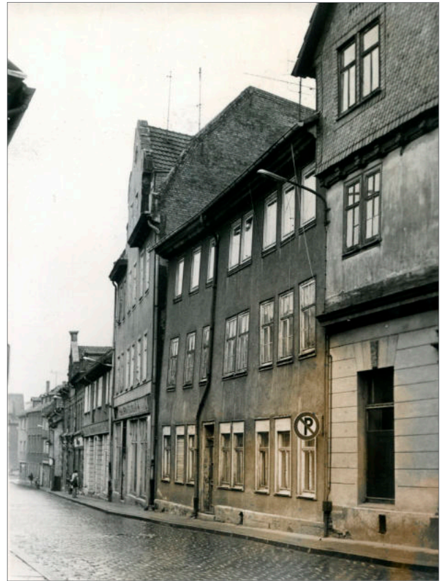
Blick in die Steingrubenstraße in den 1960er Jahren mit dem ehemaligen Wohn- und Geschäftshaus - KAISER-BAZAR - (drittes v. r.) der Familie Stern, das zur damaligen Zeit ein Sportwarengeschäft der HO war („SPOWA“). (Foto: Stadtarchiv Bad Langensalza)
