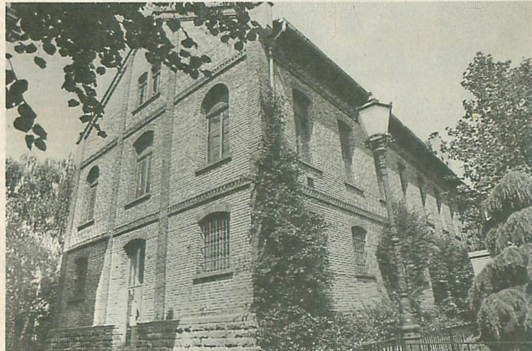
Die ehemalige Zigarrenfabrik im Herzen St. Ilgens wird renoviert.
