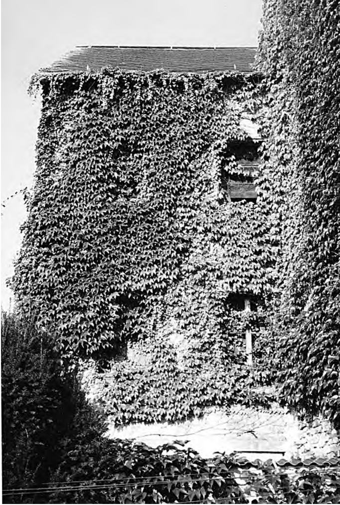
Heutiger Zustand der ehemaligen jüdischen Schule in Wawern
