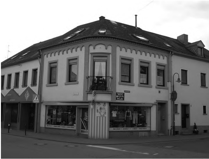
Jüdische Schule Schweich, vor 1852 auch Synagoge, heutiger Zustand
