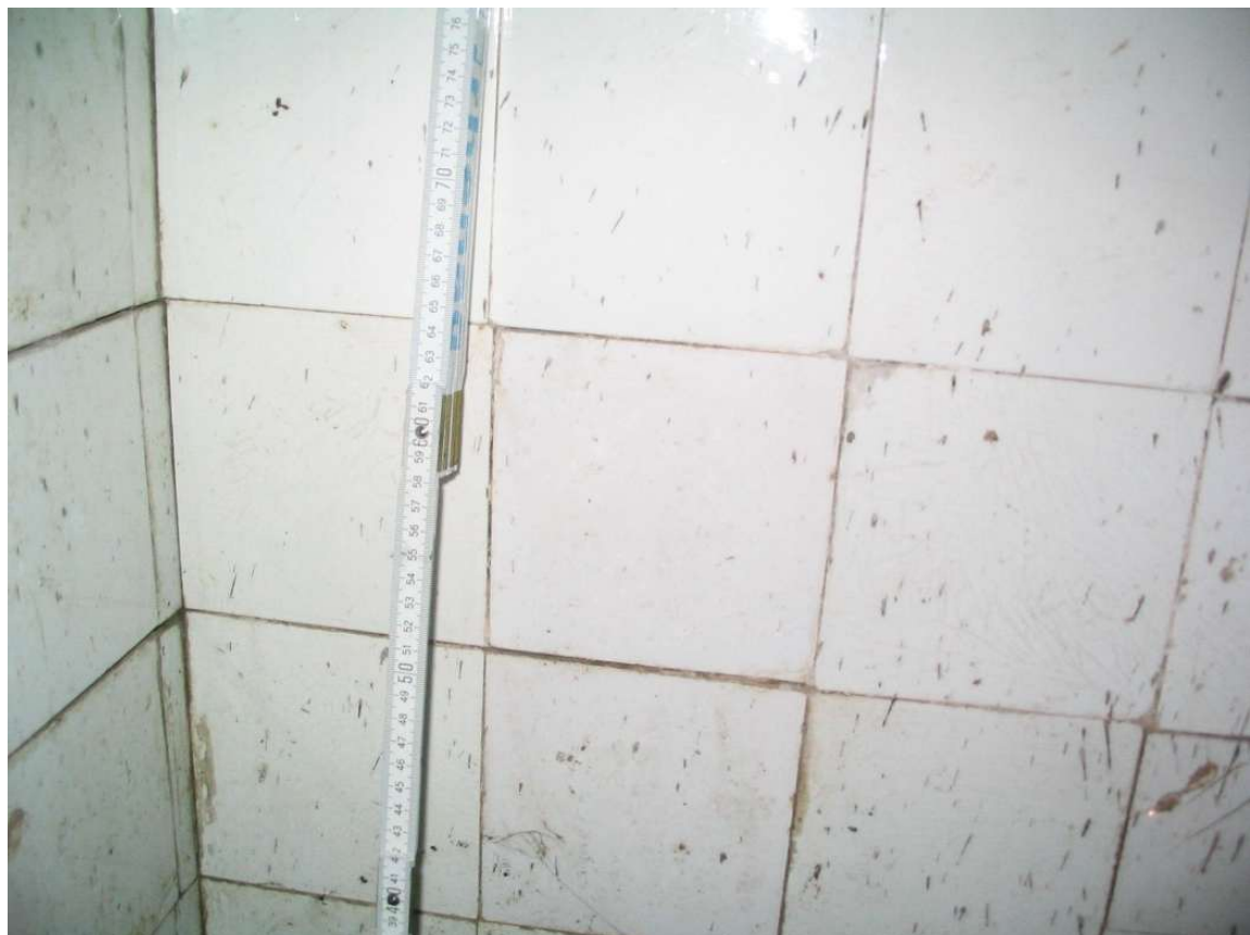
Kreuzfugenverlegung der Wandfliesen
