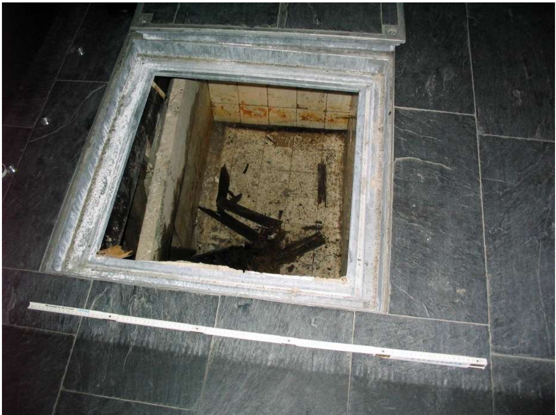
Geöffnete Fußboden-Abdeckung, Blick in die Mikwe
